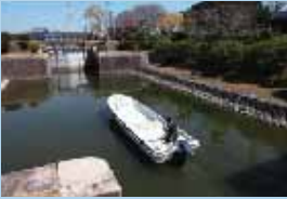
船が閘門内に入ると水門が開められ、もう一方の給排水溝を開き、閘門内の水位と船の進行側の水位を合わせる
