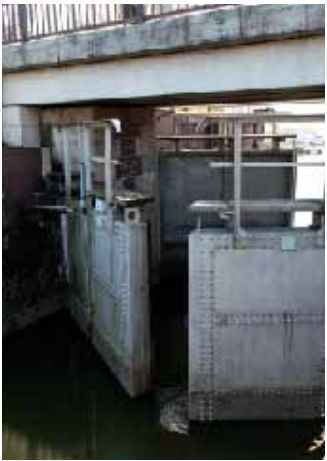
内開きと外開きの二重の門扉を持つ複開式閘門。内側の小さい扉が縦68m、横32m、重さ約9トンで、外側の大きい扉は縦76m、横32m、重さ約10トン。長良川側の閘頭部の上に機が架かっているが、構えなかった時代は門扉上部の板が張ってある狭い部分を通って対岸に渡っていたとい
